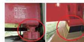
交換前(鋼製支承) 交換後(免震ゴム支承)
