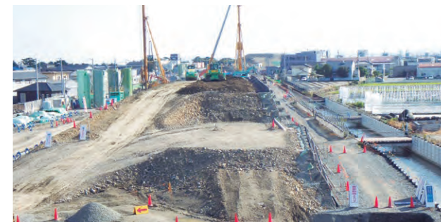
建設発生土の受け入れ
