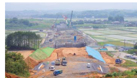
工事が着々と進む盛土区間
