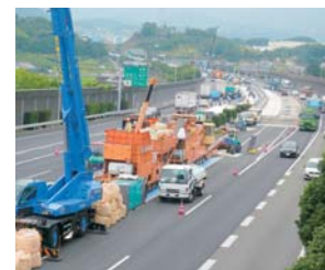
中国自動車道での集中工事規制
